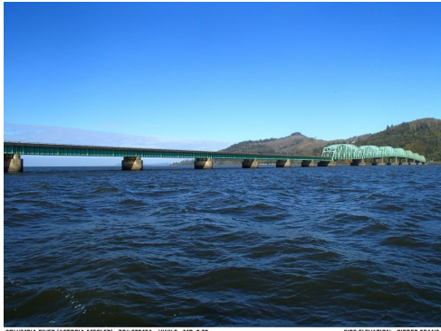
WA End Trusses
